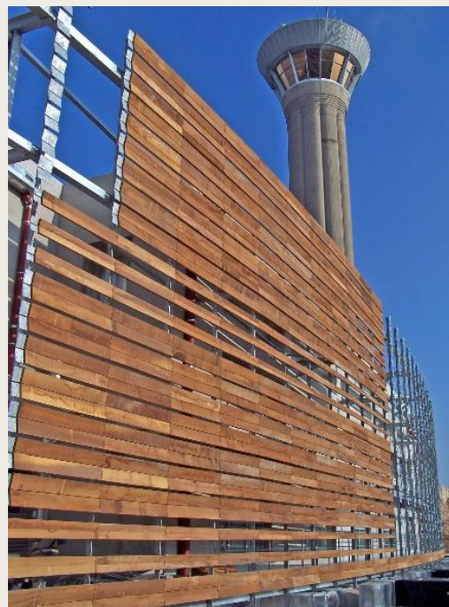
Photo : Façade brise-soleil © M. Vernay
