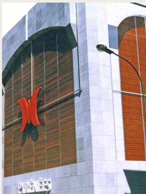
Photo : Aménagement de façade en bardage bois © M. Vernay
