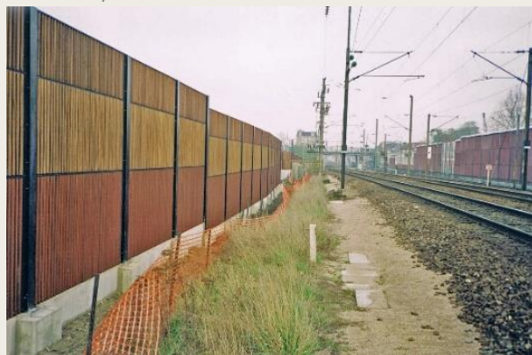
Photo : Ecrans acoustiques absorbants sur voie de chemin de fer © M. Vernay
